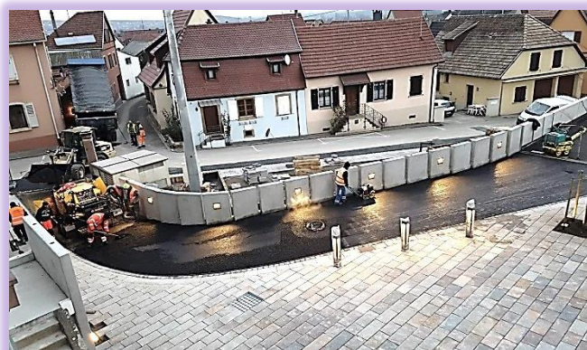
Mise en place des enrobés
