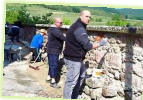
Réfection du mur du cimetière
